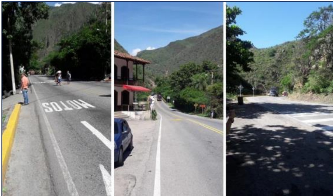
Fotografía 59. Imágenes de la vía Troncal Oriental a su paso por el sector de Pescadero. Fuente: Consultor, 2021
