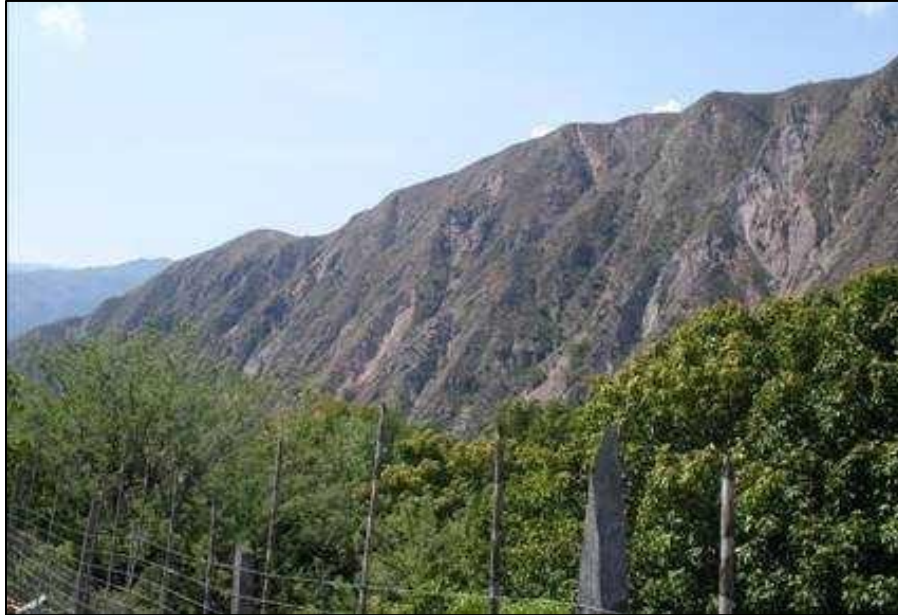
Fotografía 15. Ladera afectada por una serie de deslizamiento, vereda Umpalá Centro, cañon del río Umpalá.
