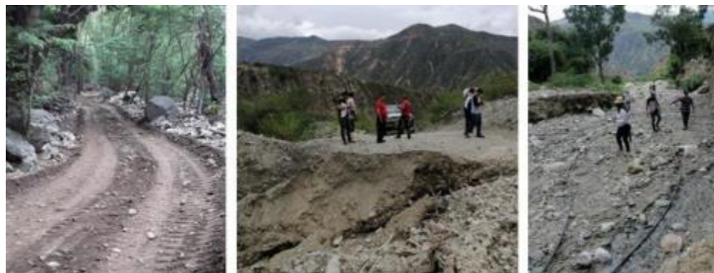
Fotografía 62. Carreteable en vereda Pavas
