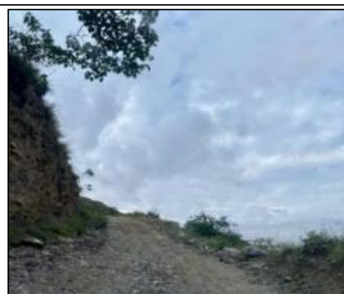
Vía terciaria que conduce al Centro Poblado Umpalá. Año 2021.
