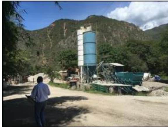
Fotografía 56. Extracción de material de construcción a nivel industrial
