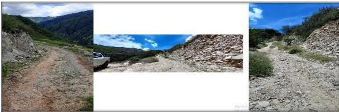
Fotografía 63. Imágenes de la vía que en construcción vereda Aguada.
