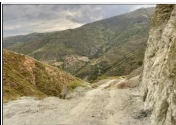
Vía terciaria que conduce al centro poblado Umpalá. Año 2021.
